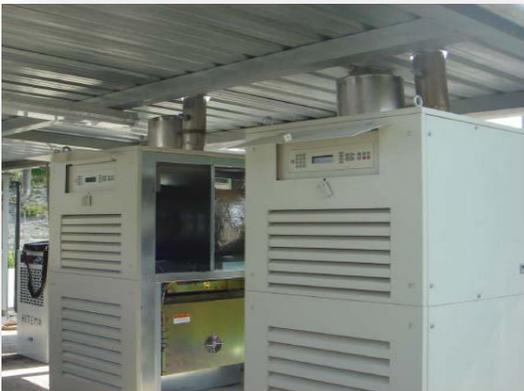
Microturbinas (2X30 kW)
